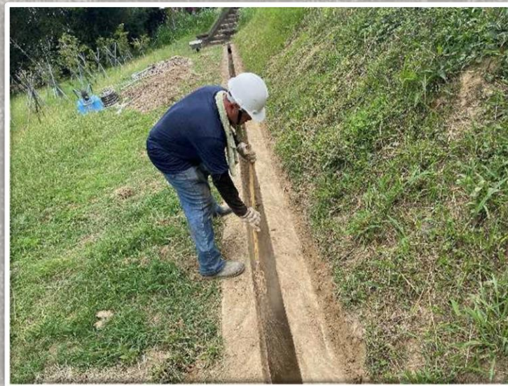
原臺南水道：日常清理水溝
