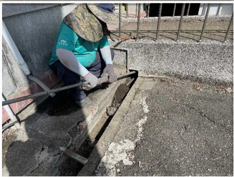
原天仁工商（傳藝中心）：清理水溝堵塞物
