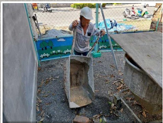
原臺南刑務所：清除積水
